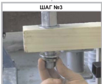
Установите плоскую и пружинную шайбу на резьбовую часть изолятора
