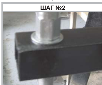
ШАГ №2 Установите изолятор с шайбой в отверстие траверсы
