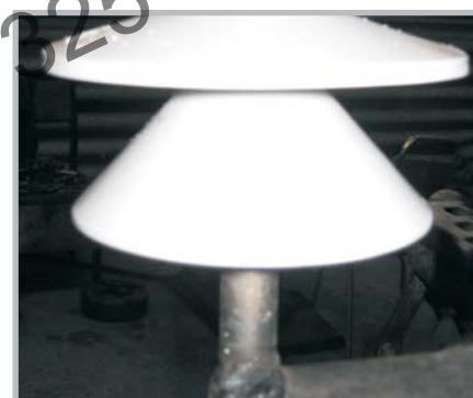
Вид установленного изолятора на траверсе
