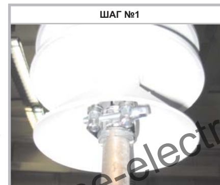
Установите изолятор на штырь траверсы
