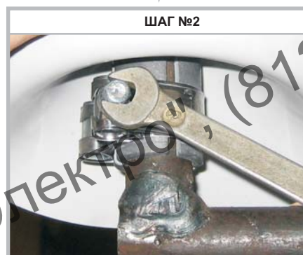
Затяните хомут изолятора на траверсе, ключом М8
