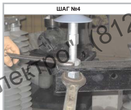
Закрепите изолятор на траверсе, при помощи двух ключей
